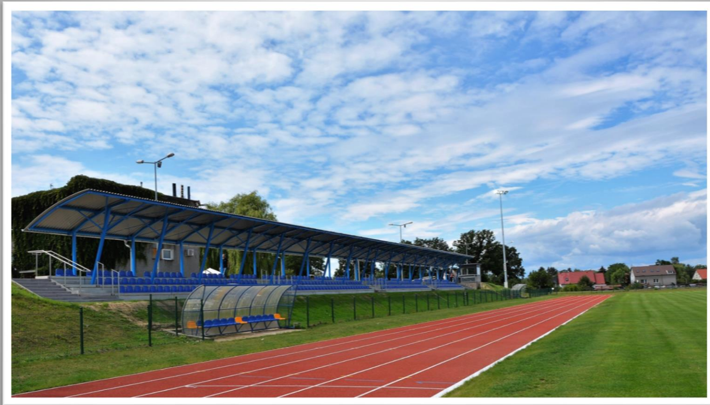
Miejski Stadion Sportowy, Kozuchów – budowa bieżni lekkoatletycznej, Certyfikat PZLA kat. V B, 4113m 2
